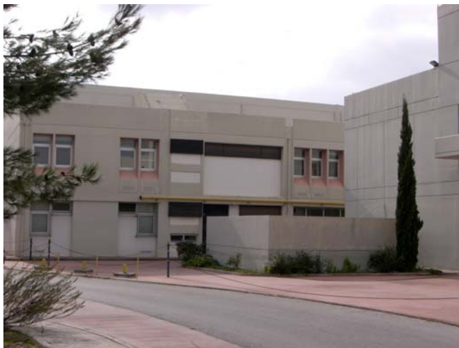
Φωτογραφία εξωτερικού χώρου στέγασης Μετροτεχνικού Εργαστηρίου και Εργαστηρίου Οργάνωσης Παραγωγής.
